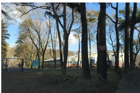
Abbildung 5: Sporthalle am zentralen nördlichen Rand des Änderungsbereichs (in Betrieb), Blick aus dem Plangebiet in Richtung Roermonder Straße
